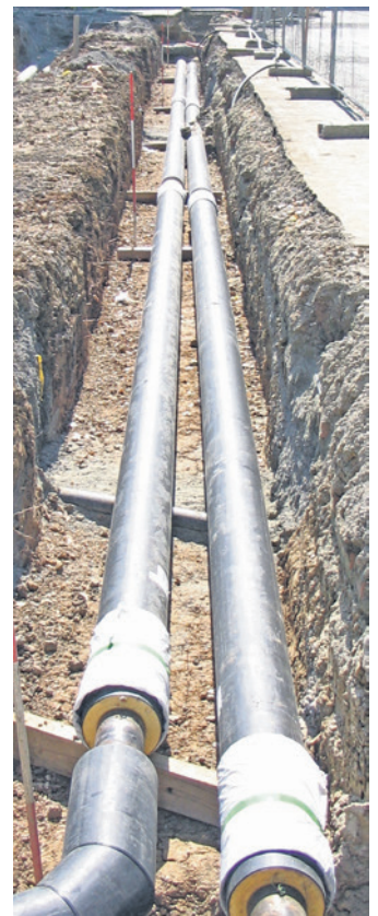
Verlegung einer Fernwärmeleitung in Deutschland.
