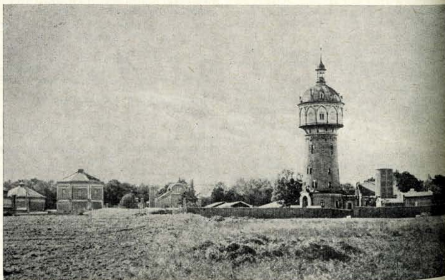
Der Memeler Wasserturm am Ostrande der Stadt
