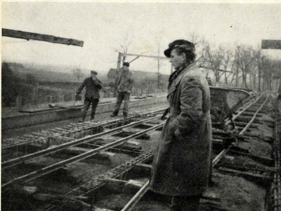
Die Kioschker Brücke über den König-Wilhelm-Kanal wird neu gebaut
